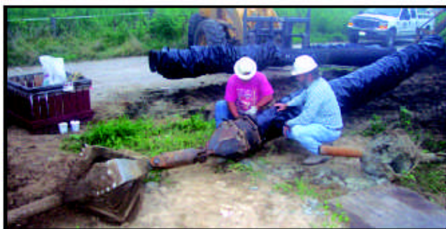
Рисунок 38 Прокладка трубопровода методом горизонтально направленного бурения.
