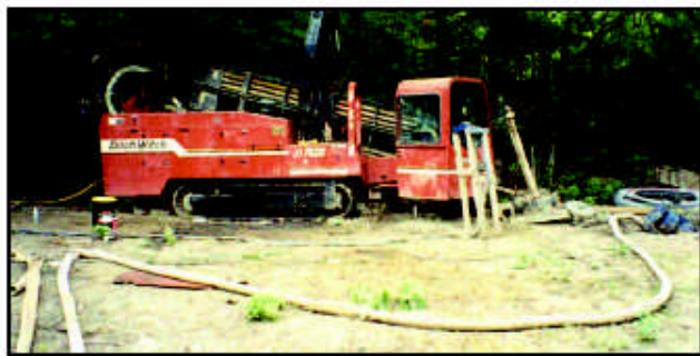
Рисунок 38 Прокладка трубопровода методом горизонтально направленного бурения.
