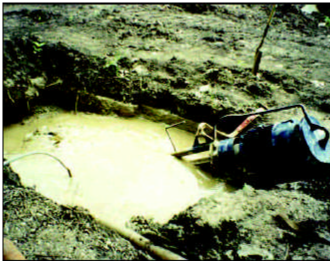
Рисунок 44 Входное отверстие для ГНБ и циркуляционный насос для бурового раствора.
