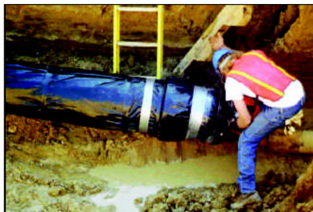
Рисунок 43 Покрытие труб полиэтиленовым рукавом.
